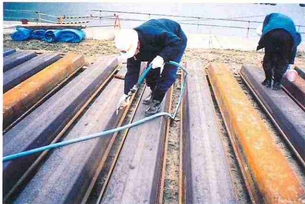
写真—3 平置きでのエアブローと流し込み
