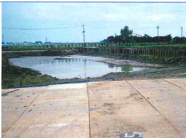
写真—16 土留工法
