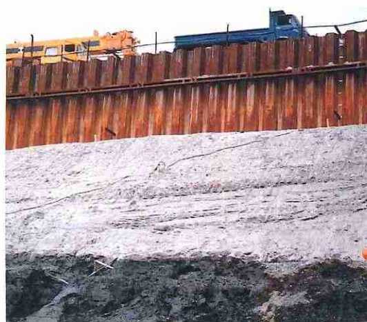
写真—15 土留工法
