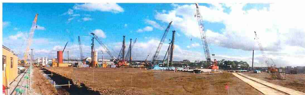
写真—18 遮水壁工法
