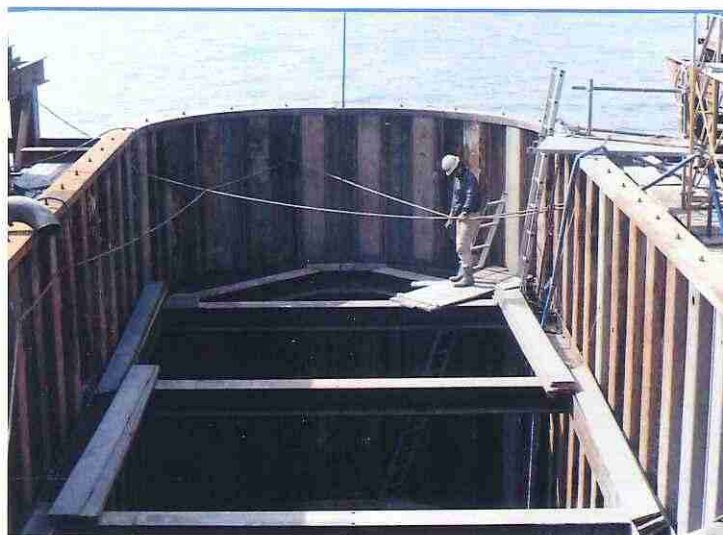
写真—14 ケーソン工法
