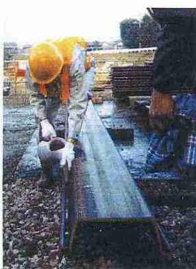
写真—6 流し込み
