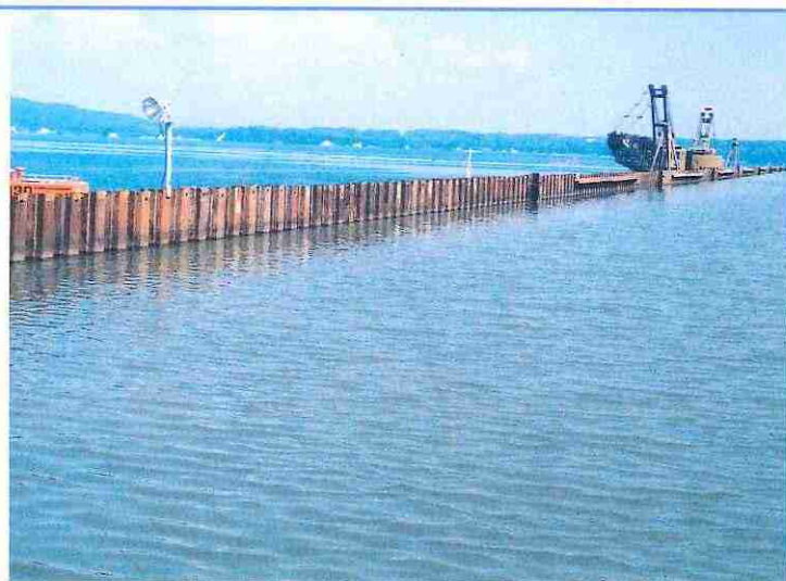
写真—13 締切り工法
