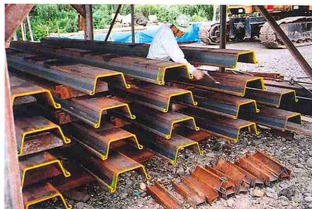
写真—4 重ね置きでのエアブロー
