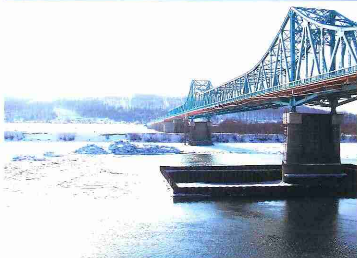
写真—17 遮水壁工法
