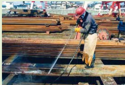
写真-12 ウォータージェットによる清掃作業
