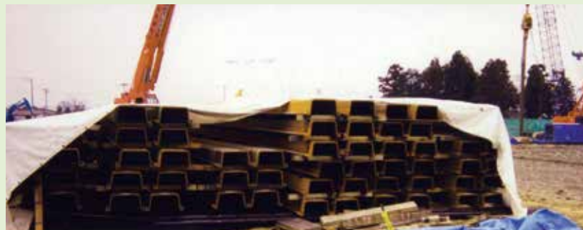
写真-10 養生(硬化)の例
