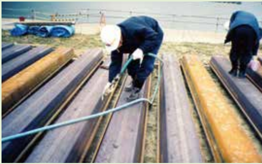
写真-3 鋼矢板の平置きとエアブロー作業
