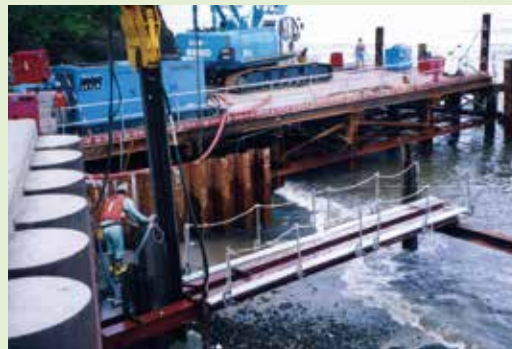
写真-11 打込みの例
