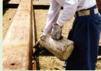
写真-9 流し込み
